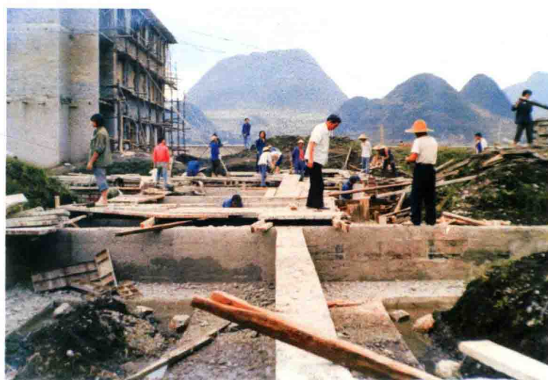
学校建设施工现场
