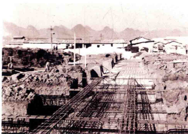
1987年2月学生宿舍楼基础建设
