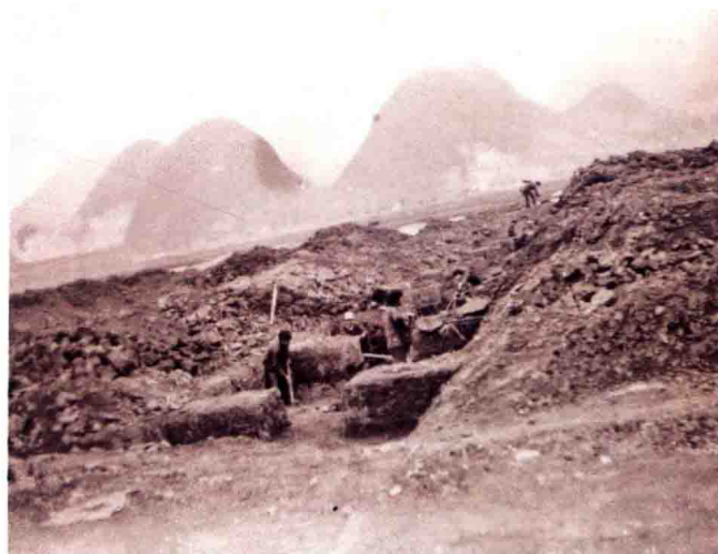
第一教学楼基础开挖
