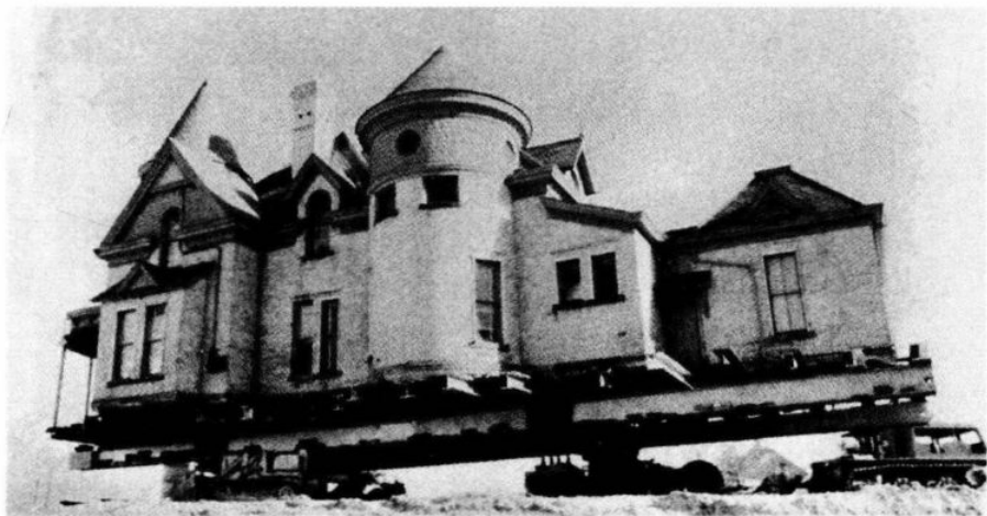
1981年 - 建筑的真实特点——它们难以做到静止不动——在一所正在搬迁中的砖房子中展露无遗，这栋房子位于北卡罗来纳州的罗利市。为了给州政府的办公楼建设腾地方，凯普哈特 - 克罗克府邸（1898年）搬迁走了。这栋房子现在用来办公。
