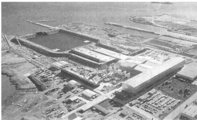
图 1-4 厄勒海峡沉管隧道预制厂
