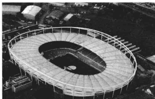
图 1.4.3-2 单层环索双层环梁环形索桁结构
