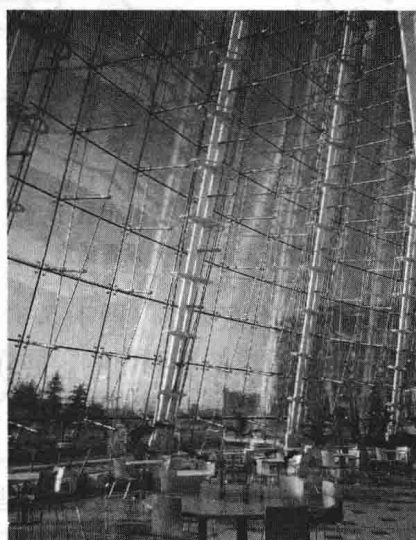
图 1.4.8 双层索系幕墙结构
