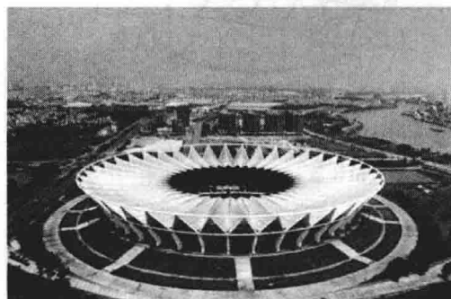
图 1.4.3-3 折面型环形索桁结构
