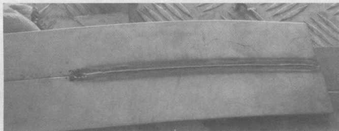
图 1-3 平对接焊缝引弧/收弧处的焊接缺陷 (二)
