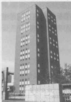
图 1-2 装配式混凝土建筑（沈阳丽水新城——我国最早的一批装配式建筑）
