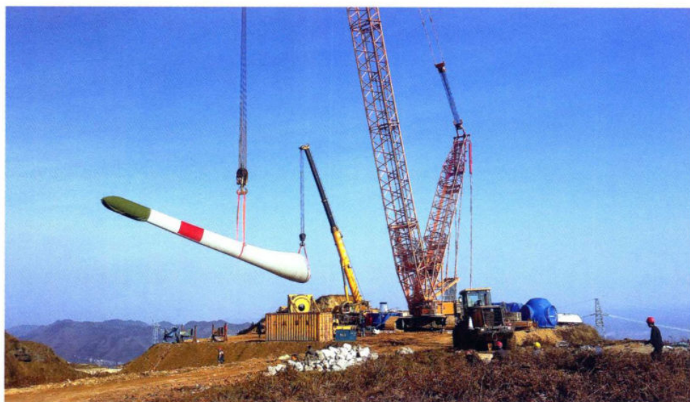
2016 年元月，晴隆苏 家屯风力发电场 17 # 风机 叶片吊装现场 （杨浩摄影）
