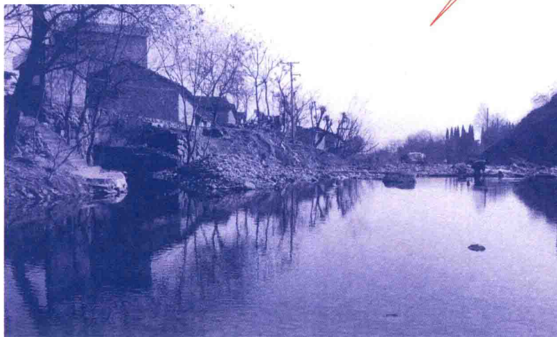
芳溪堰进水口
