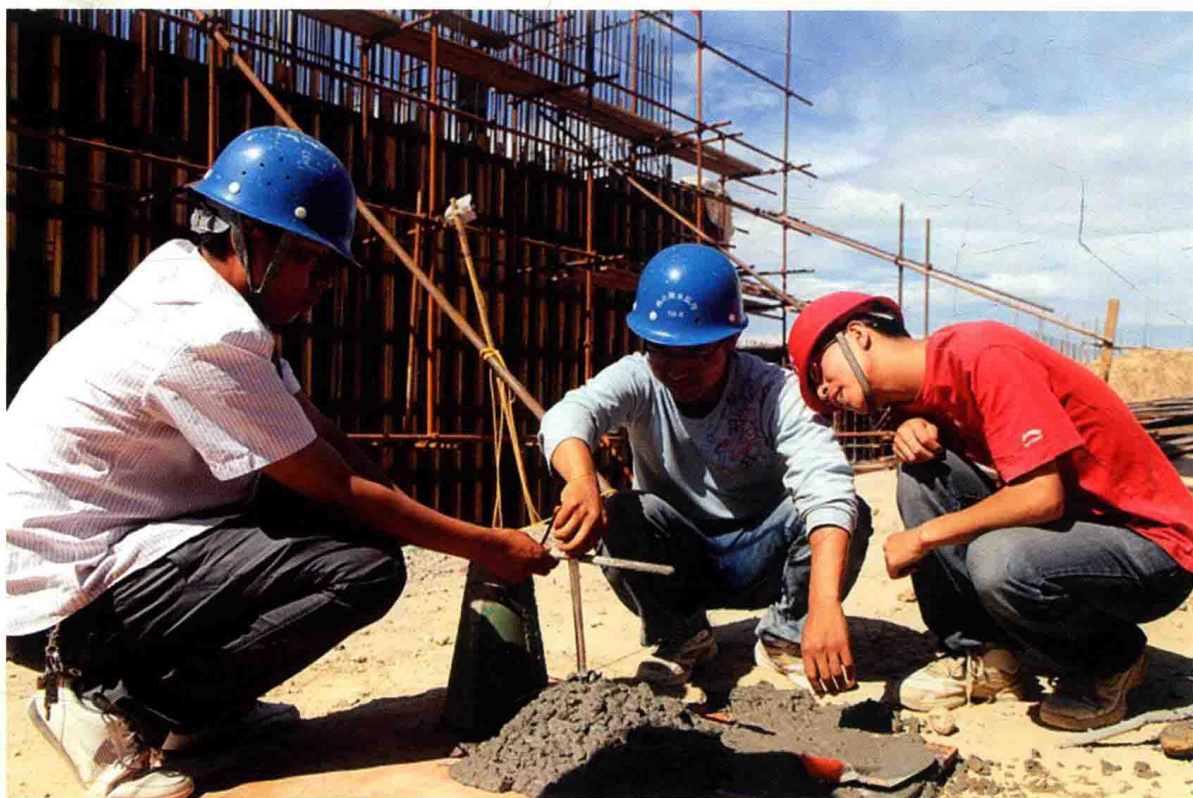
监理人员现场检测混凝土坍落度
