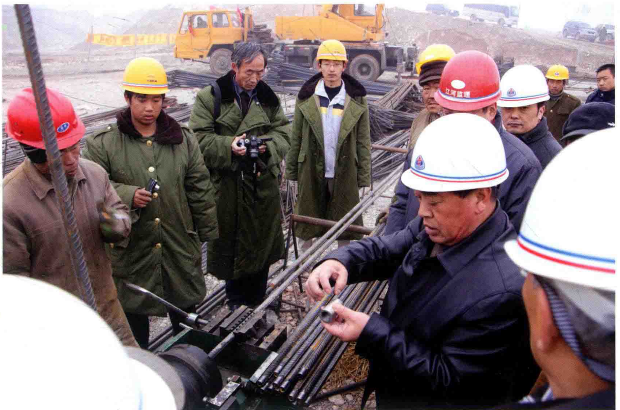
2009年11月，专家检查钢筋套筒连接质量
