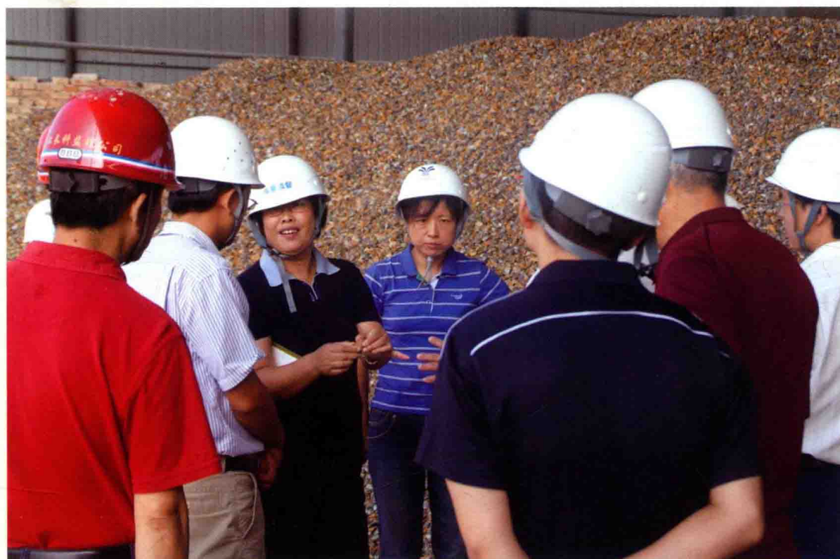
2010年8月，南水北调工程建设监管中心检查原材料质量
