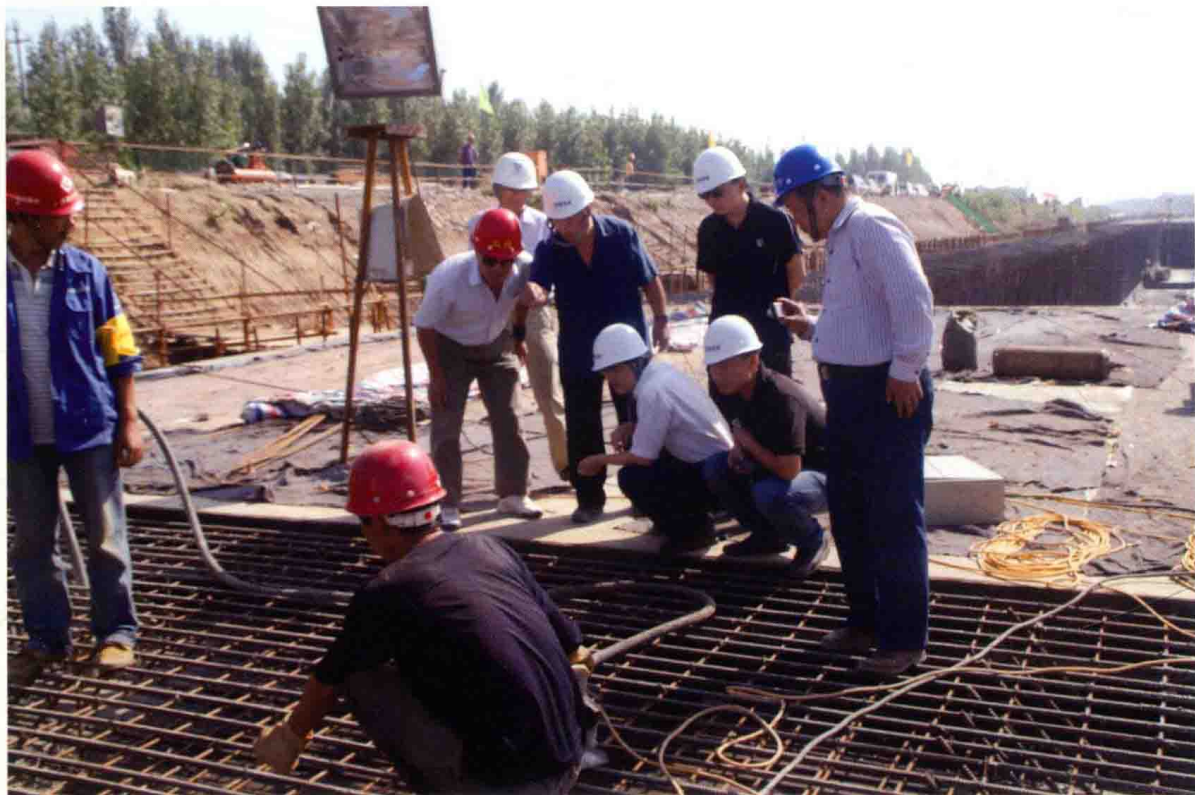
2010年8月，专家检查指导混凝土浇筑
