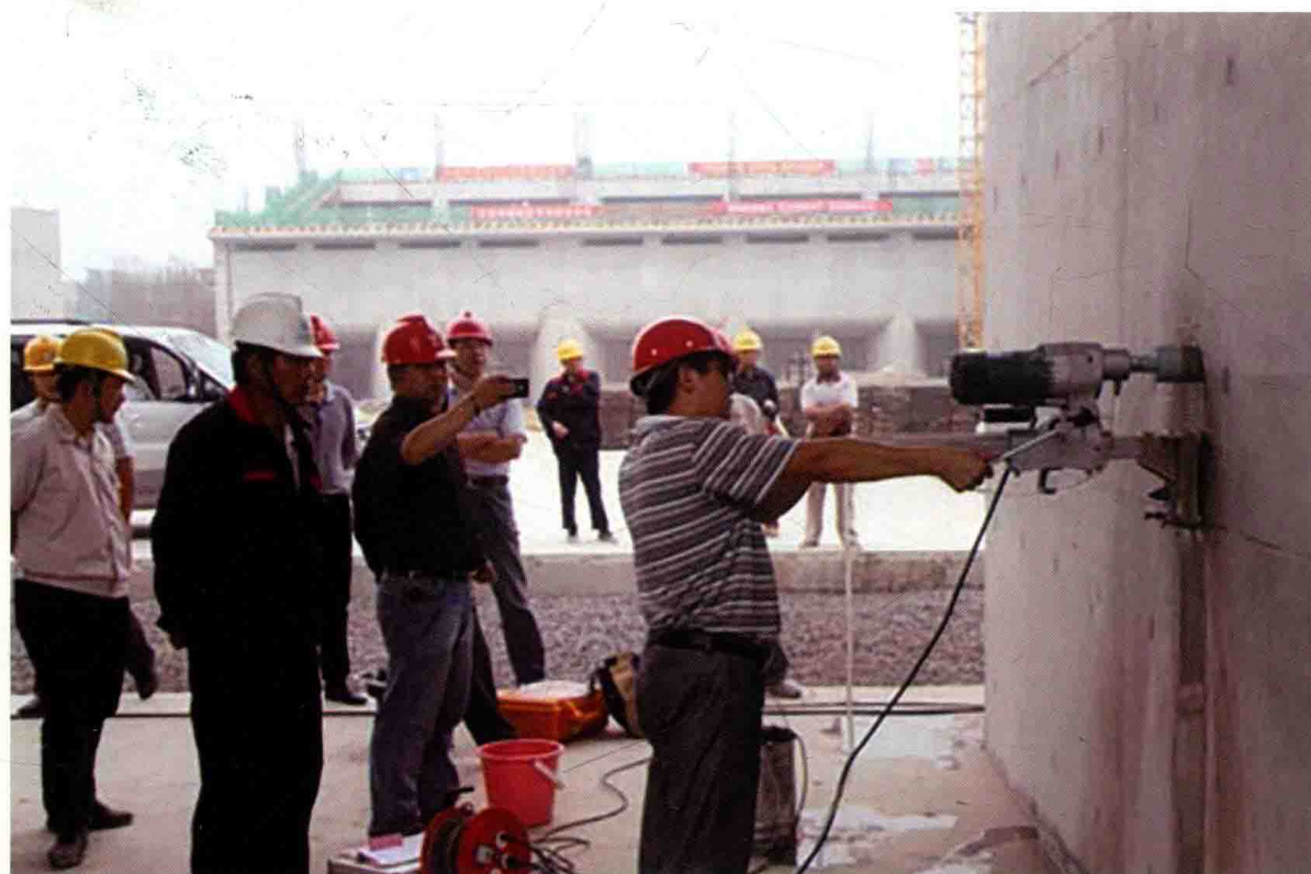
泵站进口流道侧墙混凝土取芯
