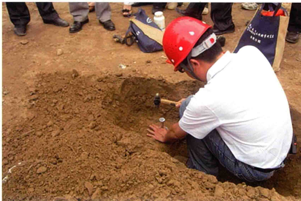
环刀取样检测回填土压实度
