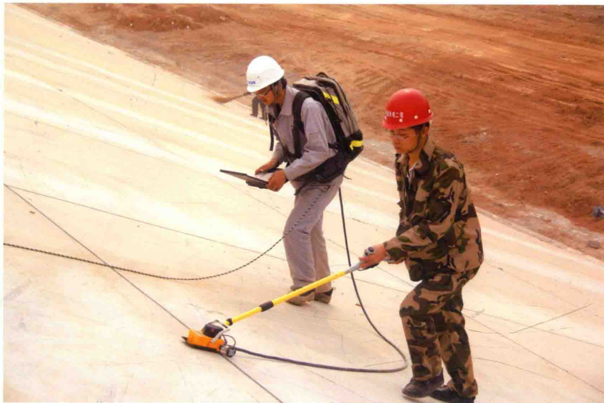
渠道边坡衬砌质量检测
