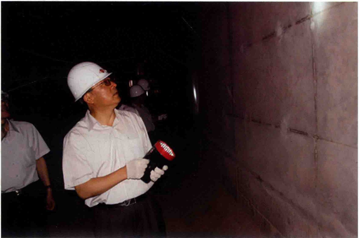
2011年6月，国务院南水北调办副主任张野检查实体工程质量
