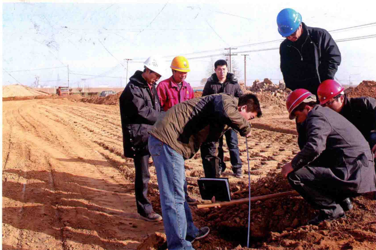
质检人员检查高填方段回填土厚度
