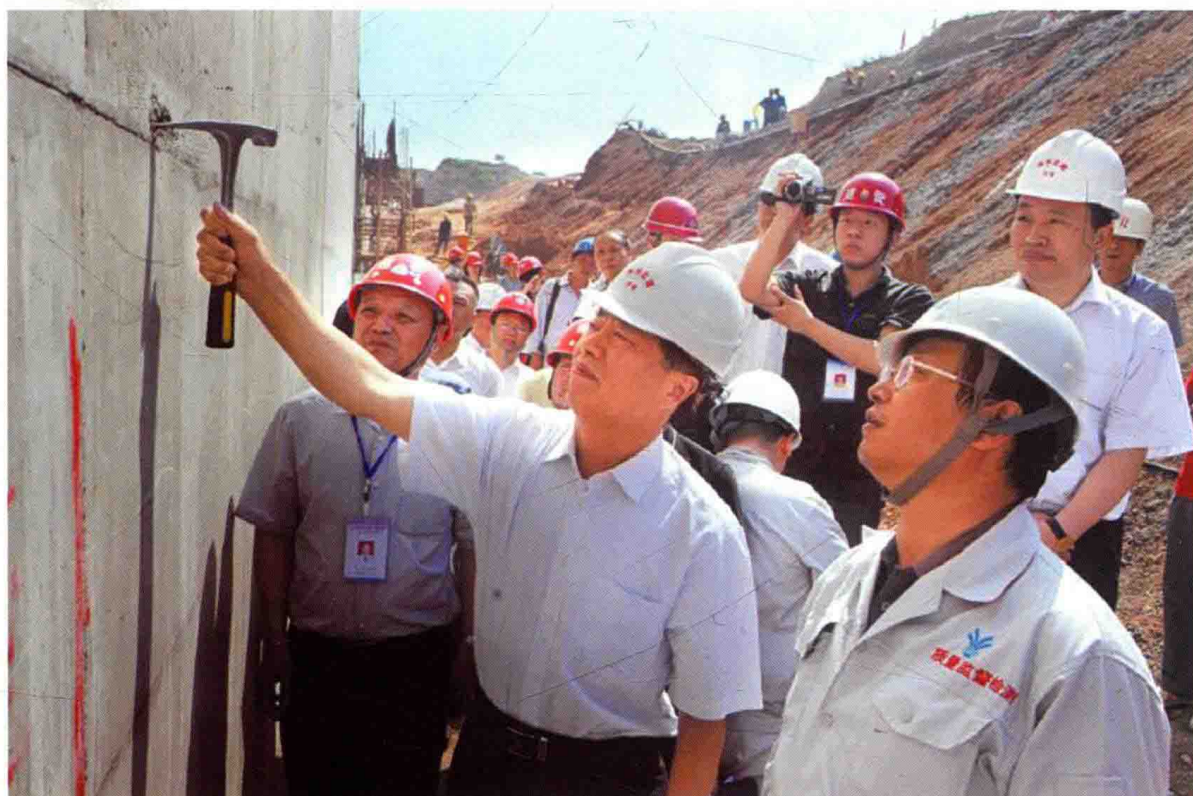
2012年5月，国务院南水北调办主任鄂竟平检查中线禹长段工程混凝土施工质量
