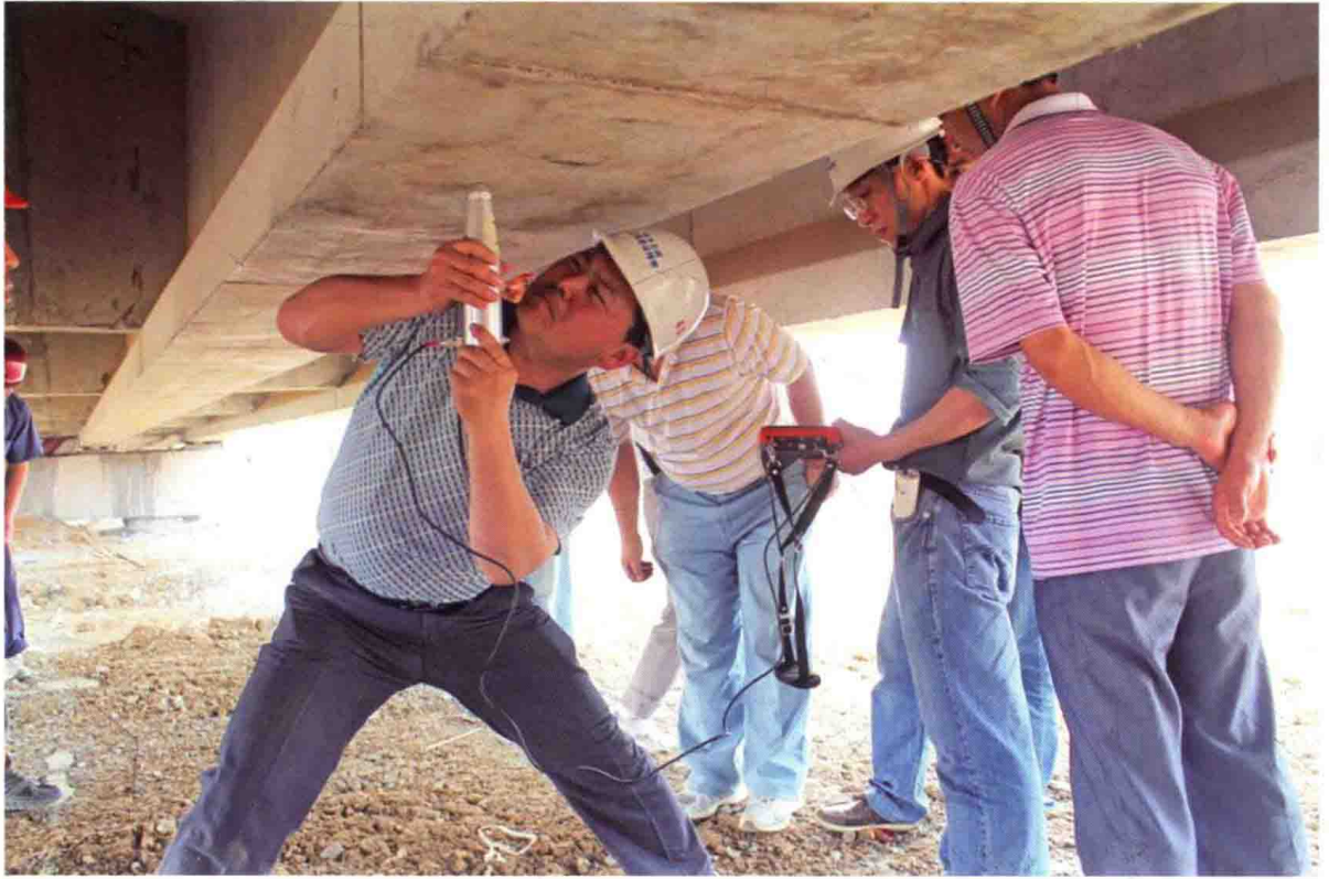
渡槽混凝土强度检测
