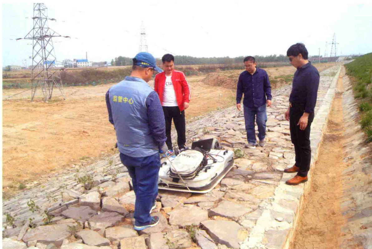
探地雷达检测渠道边坡
