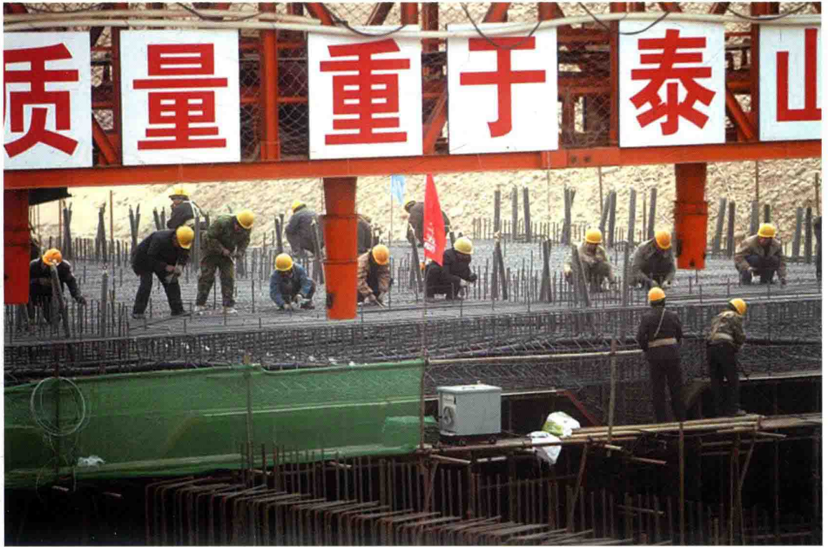
2011年1月，中线郟石段南沙河倒虹吸管身段浇筑现场
