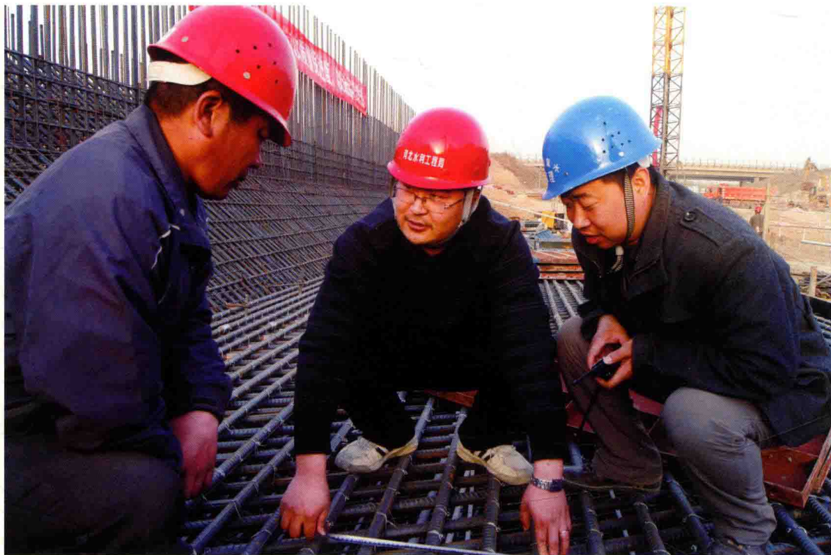
监理人员检查钢筋绑扎情况
