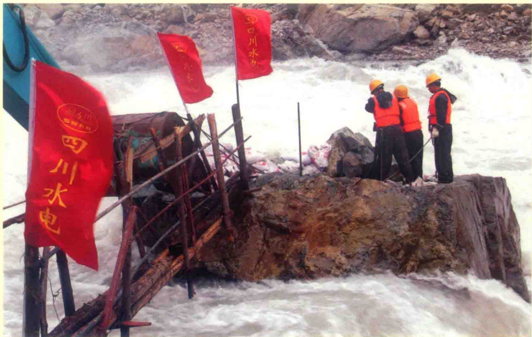
● “5·12”汶川特大地震后，形成104座堰塞湖，给下游人民生命、重要城市、铁路动脉、能源管道等造成威胁。水利厅积极采取措施，果断、安全、迅速处置堰塞湖。图为四川水电工程队在汶川老虎嘴壅塞体排险。
