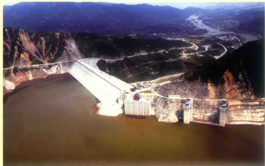
● 2006年6月建成的紫坪铺水利枢纽工程
