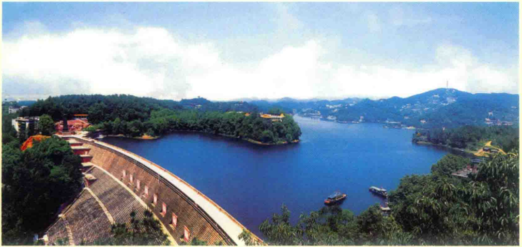
● 黑龙滩水库大坝全貌
