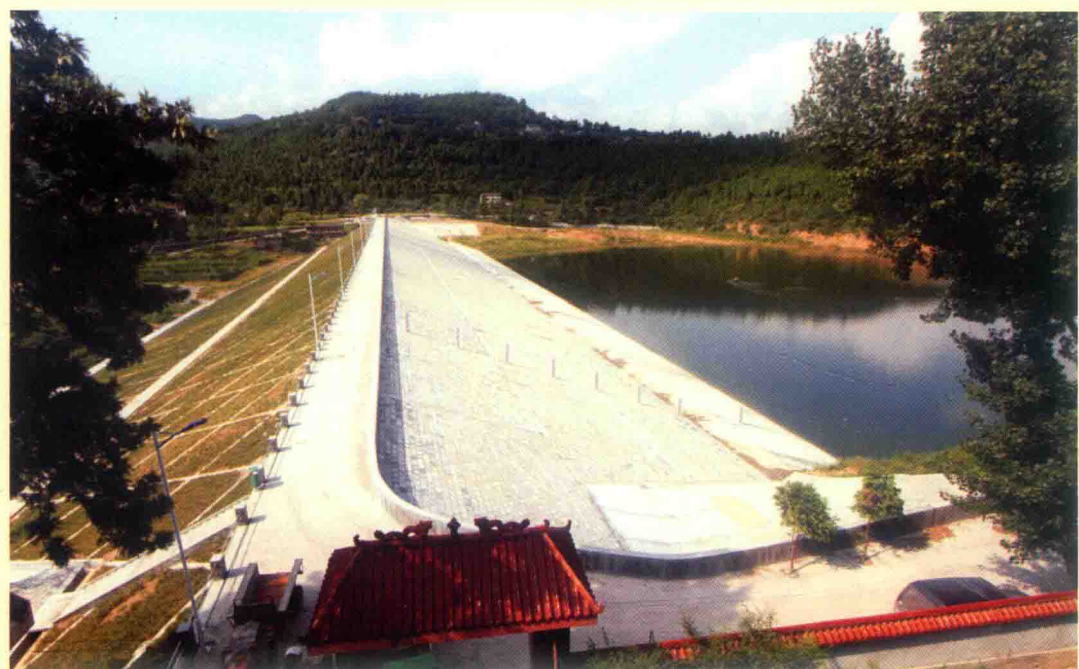
●从2002年开始，四川集中人力、财力、物力，强力推进病险水库整治工作，实现了“整治一座水库，还一库清水”，保证了群众生命财产安全。图为重建后的苍溪阎家坝水库大坝。
