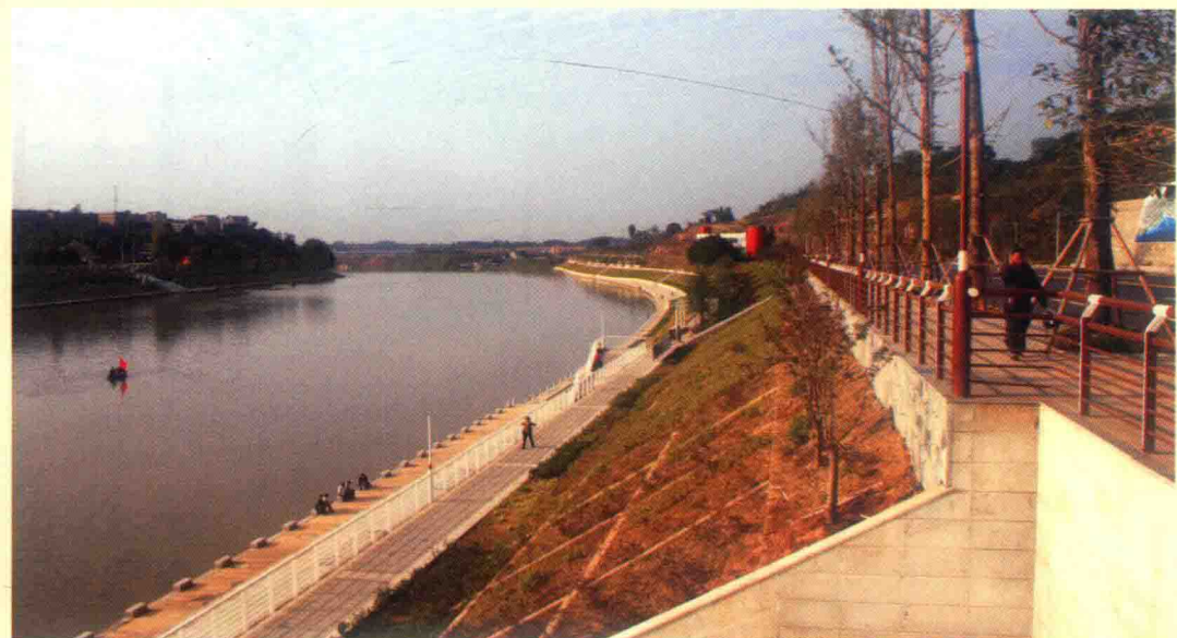
●2011年，四川省委要求进一步加强防汛抗旱工程建设，构建水利防灾减灾保障体系，基本完成岷江、沱江、涪江、嘉陵江、渠江、雅砻江、长江上游干流“六江一千”重点河段堤防工程。图为沱江干流内江城区堤防工程（羊子岩-沱江四桥）。
