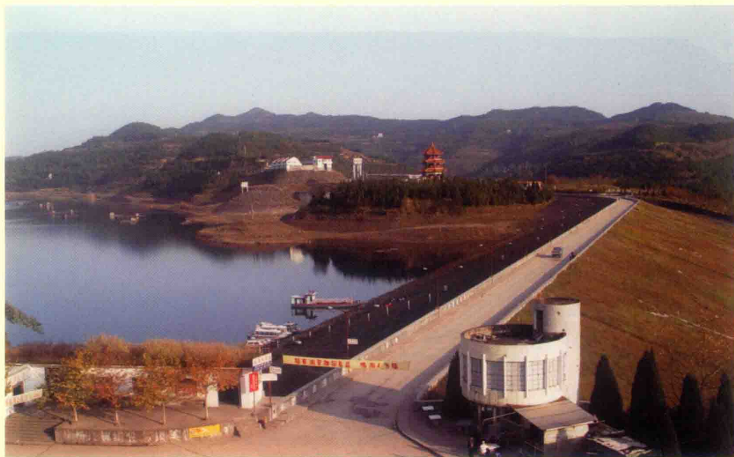
● 2012年12月26日开工建设的南部升钟水库大坝
