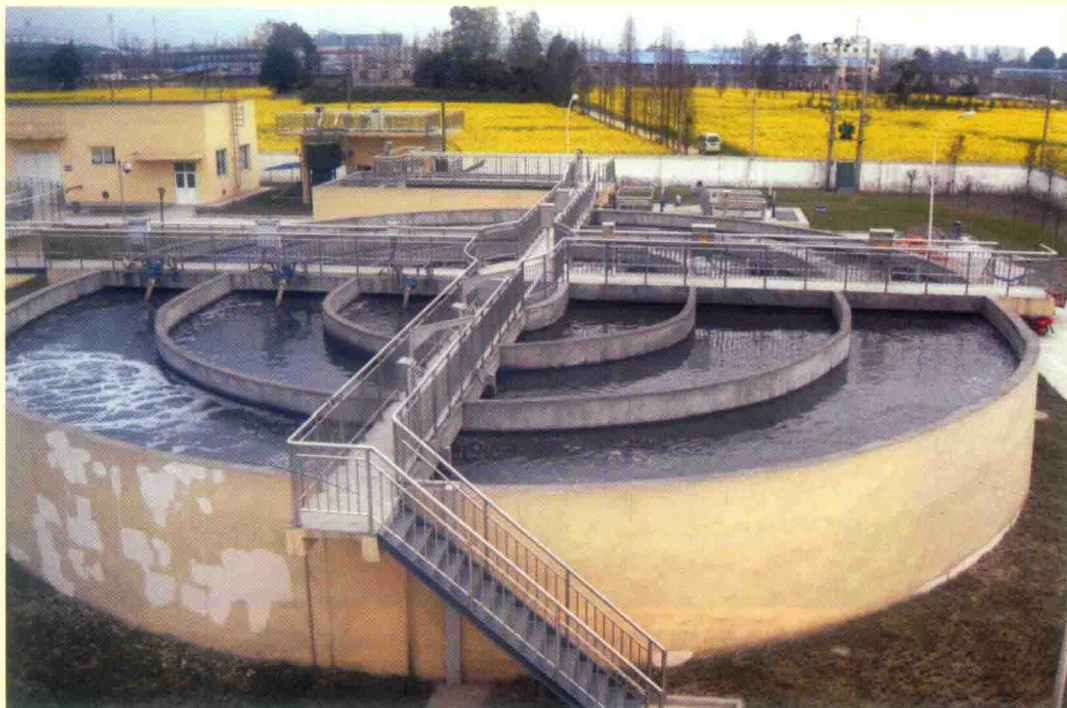
●为改善人民生活用水质量，双流县水务局于2009年筹备建立了九江、金桥、彭镇等6座污水处理站，提高了污水处理能力。图为彭镇污水处理站。
