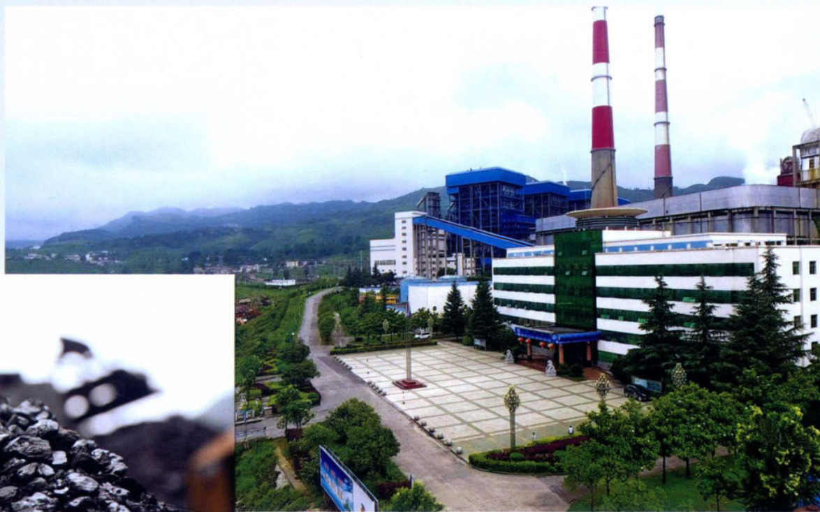
>> 航拍阳长火电厂 谢健锋|摄
