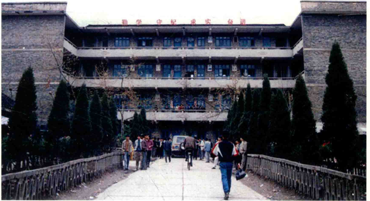
1980年8月建成的教学大楼
