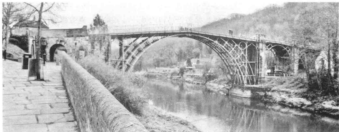
图1-1 铸铁拱桥（英国，煤溪谷 设计师：达比和威尔金森，1775~1779年）
