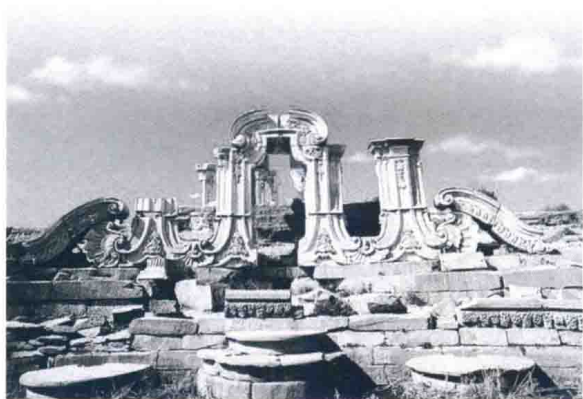
● 图 1-2 圆明园建筑遗址
