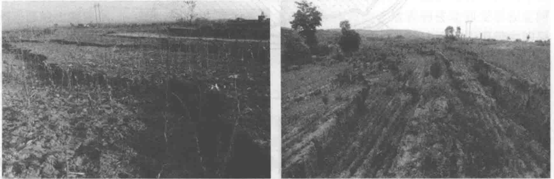
图 1-11 某矿采煤工作面开采地表台阶及地堑式裂缝
