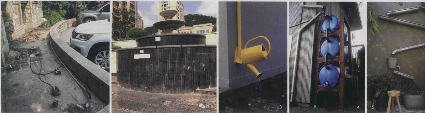
1-2.未喷放的喷泉 3-5.雨水管设计
