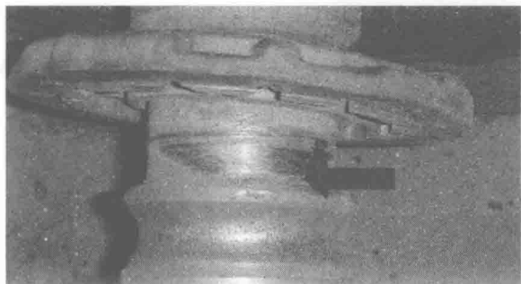
图 1-6 转子轴被内挡油环啃出环状沟道
