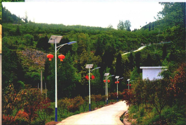
>>太阳能路灯安装到新农村 张应旭|摄
