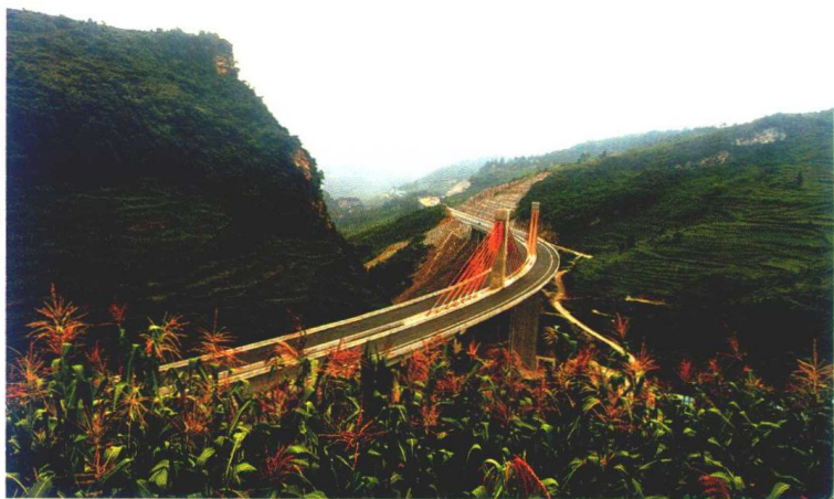
纳雍县龙井河曲线矮桩斜拉桥 祝 维 | 摄
