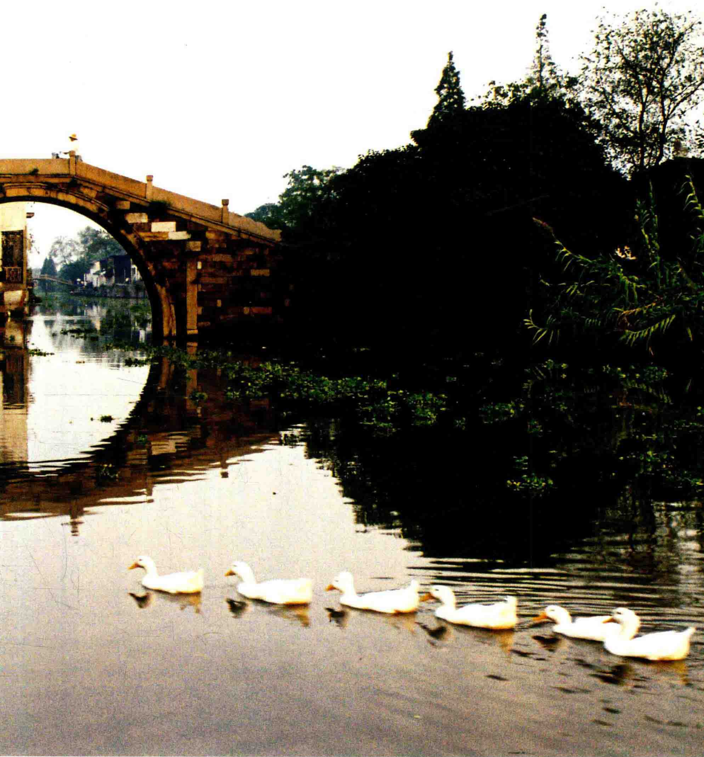
西栅双桥，雅称通济桥和仁济桥。两桥直角相连，相映成趣，素有桥里桥之称。东西向的为通济桥，俗呼西高桥，始建年代不详，明正德十年（1515）重建，后世屡毁屡建，现桥为同治六年（1867）里人邱雨樵募建；南北向的为仁济桥，俗呼栅桥，明正德十三年（1518）改建石环桥，咸丰间毁于太平天国，同治间重建，延至今日。
