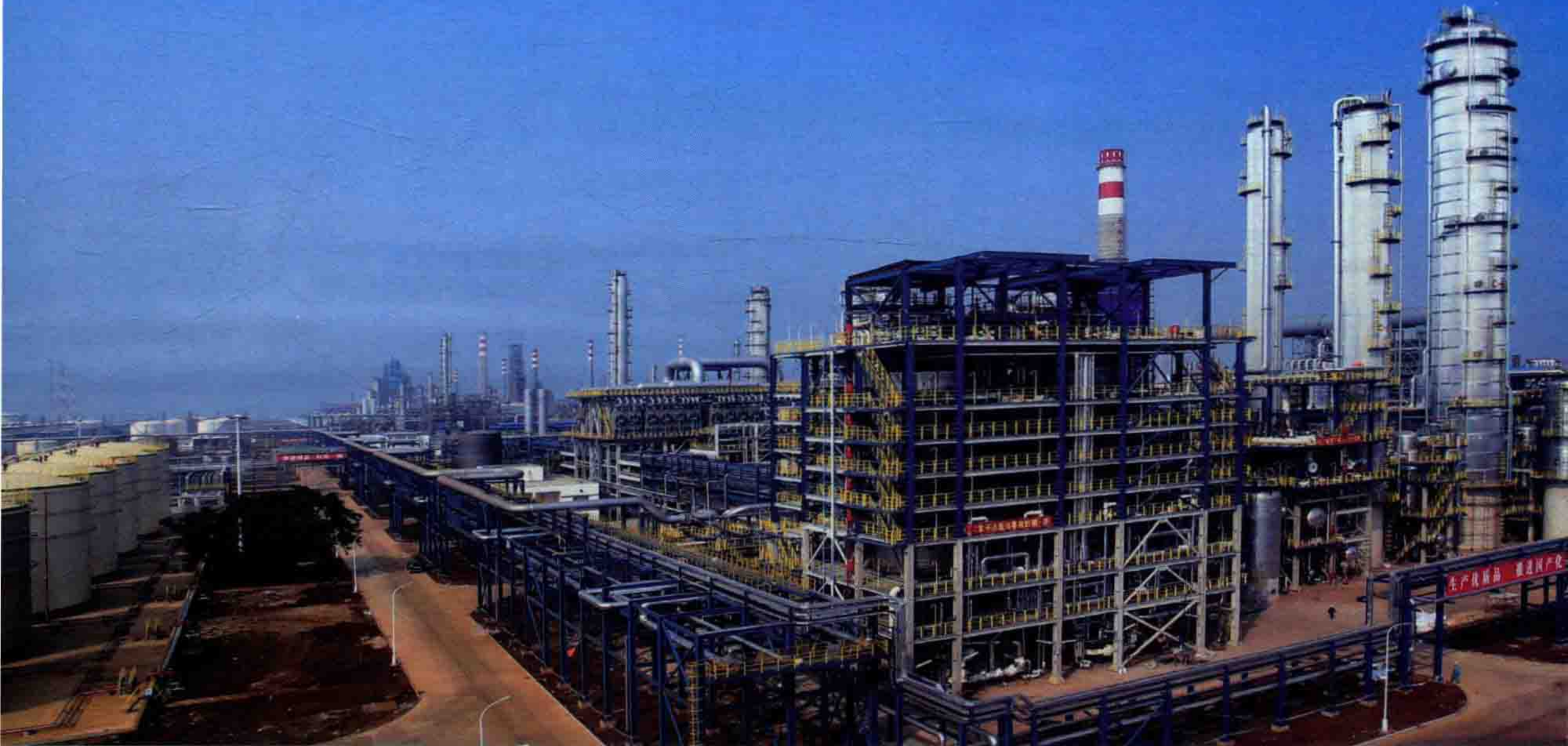
海南炼化 310 万吨 / 年渣油加氢处理装置
