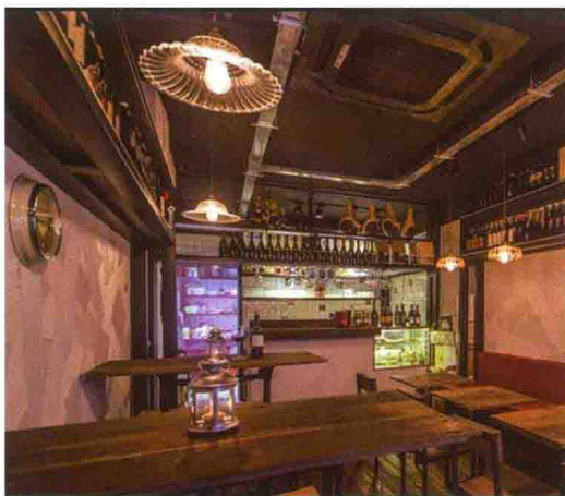
图 1-17 建筑原始顶棚
