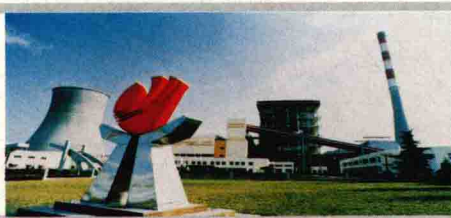
禹州电厂(安装)
