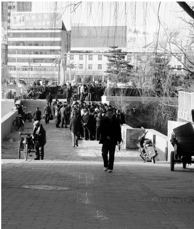
图 1-8 榆林市老榆阳桥
