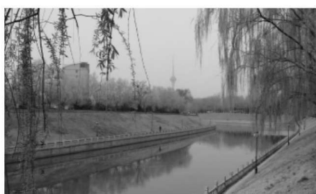
(a) 上缓下陡的复式断面
