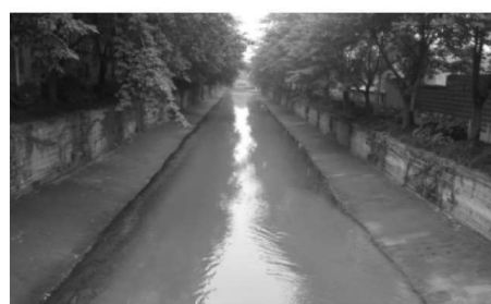
(b) 上陡下缓的复式断面
