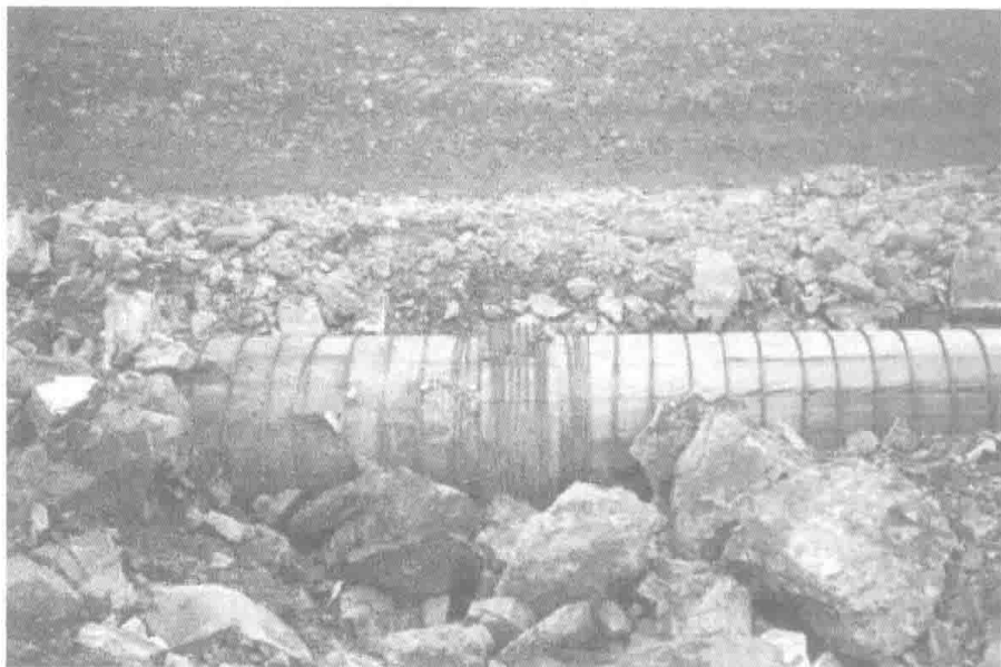
图 1-2 建于 20 世纪初的一段木板管道
