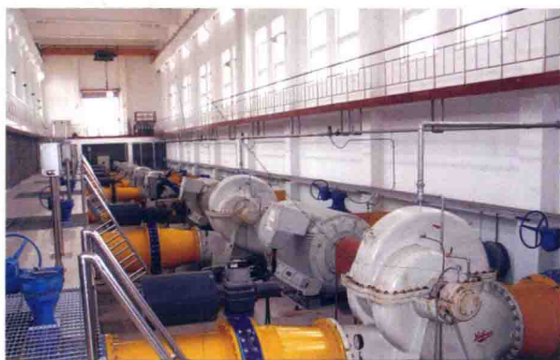
温州水务局新状元供水厂增压泵 (SX700-800型中开泵)
