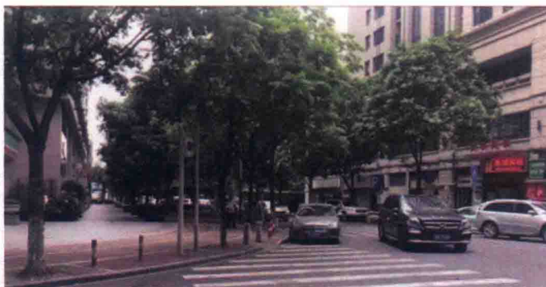
图2 转弯半径大导致车速偏高、转弯处乱停车
