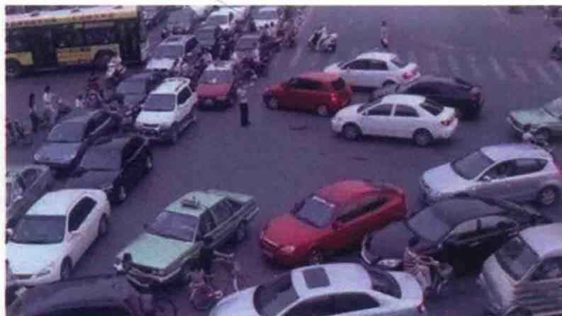
图3 平交口没有导流岛，人车冲突严重
