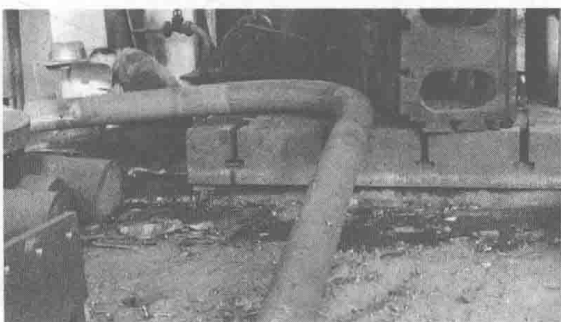
图 1-6 焊接管子的环缝 (大型容器内部的物料输送管)
