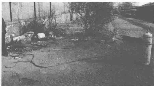
图 1-15 乙炔瓶必须直立放置
