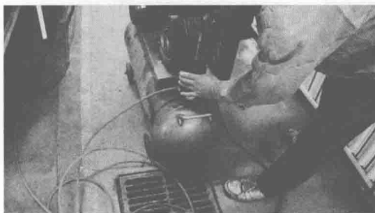
图 1-13 电工在检修气泵 (空气压缩机)
