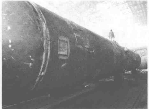
图 1-7 用转罐机对大型塔体进行卧装后的焊接位置调整
