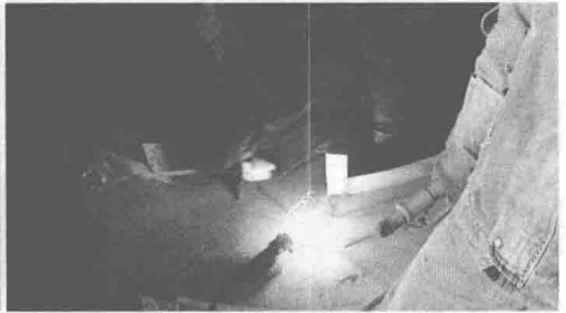
图 1-12 装焊塔体内部的零件 (使用有防护罩的移动照明灯)
