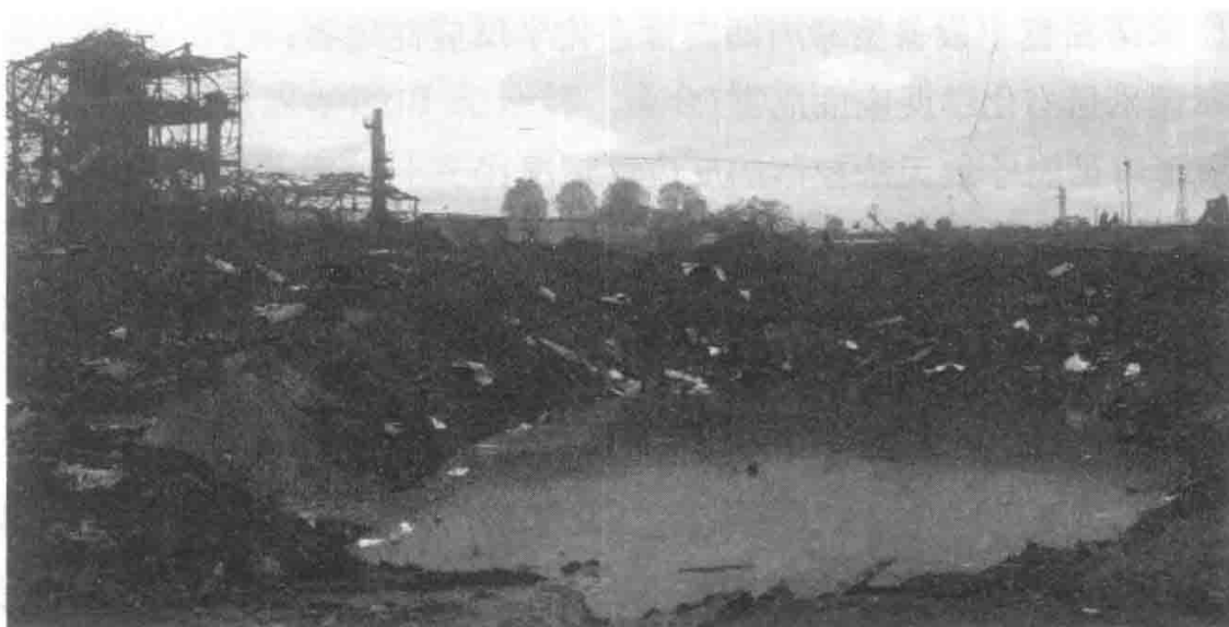
图1.1 法国图卢兹附近爆炸形成的泥坑(路透社提供)
