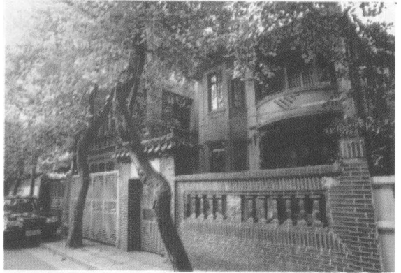
广州传统民居建 筑——新河浦三 横路侨房
