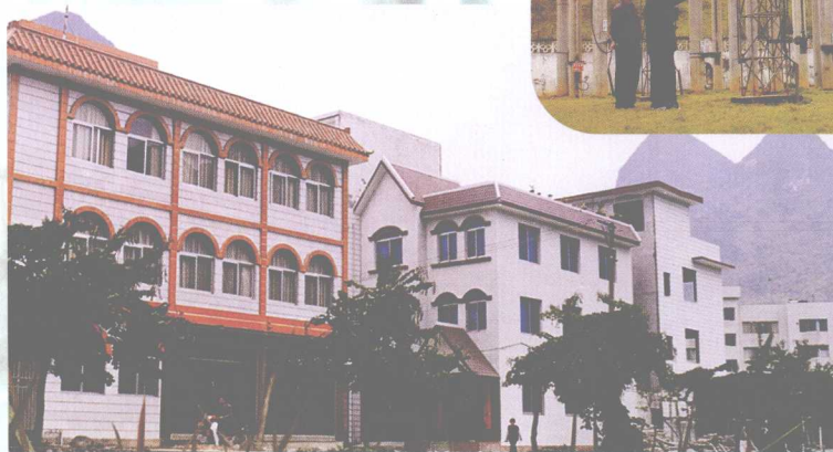
◀ 城镇居民住宅楼
