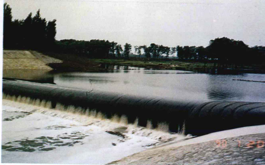
拒马河橡胶坝
