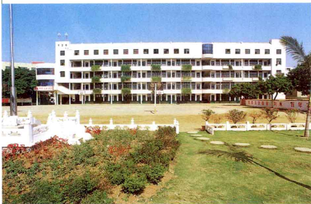
▲ 莆田市涵江实验小学新建教学楼
