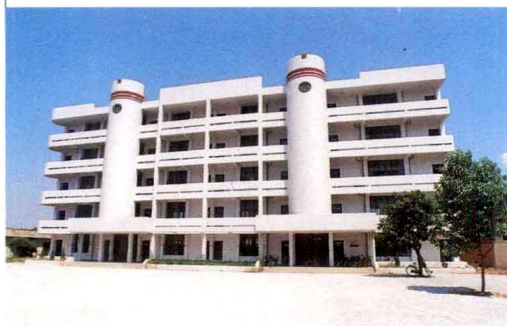
▲ 涵江区苍林小学教学楼
