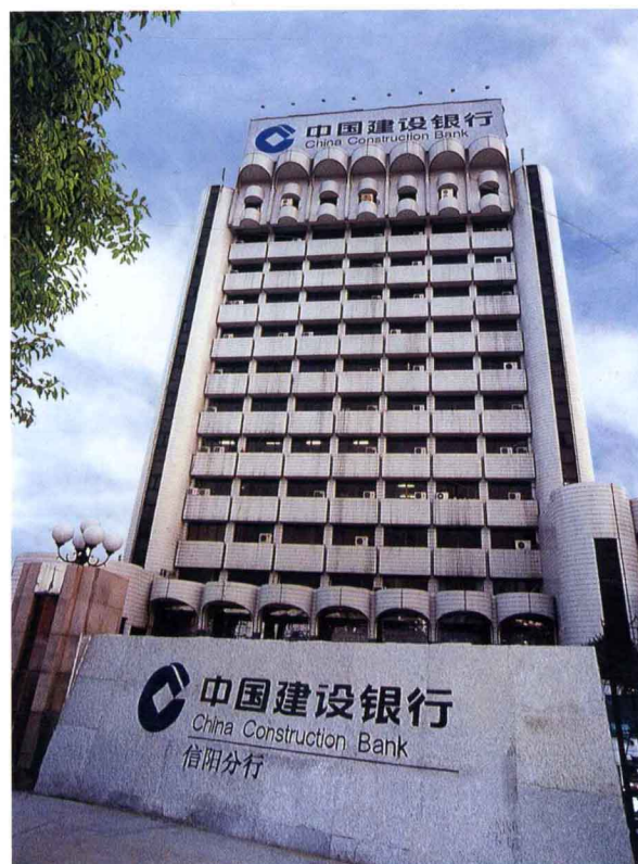
建设银行大厦
