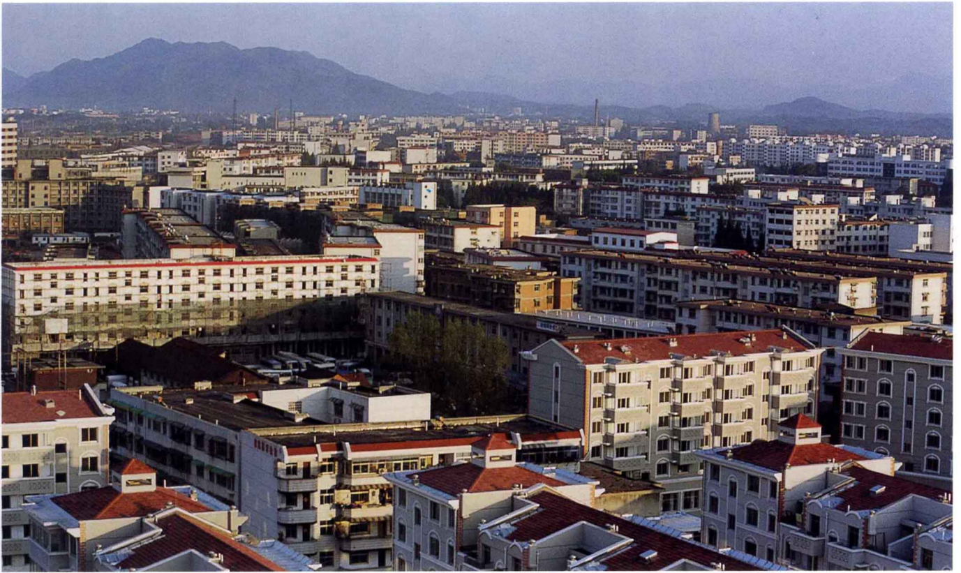
新区广厦建设
