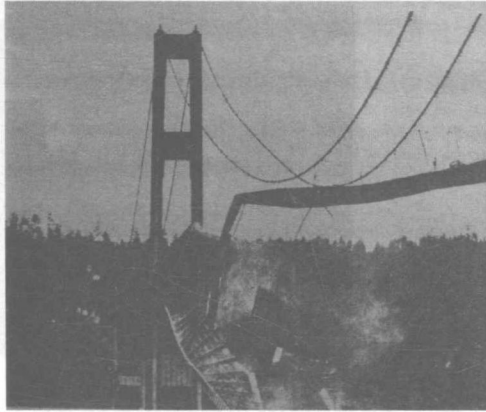
圖 1.1 由於風力導致塔科馬港市窄橋的斷裂，橋在 1940 年 7 月 1 日開始使用，在 1940 年的 11 月 7 日就倒塌（資料來源：Timoshenko, S. P., 1953）。
