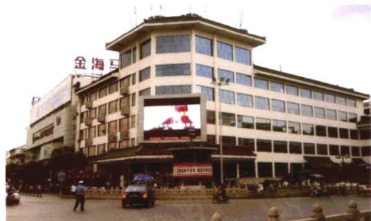
人民路察院场邮电大楼
