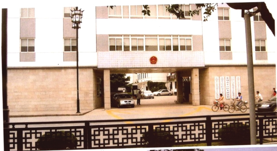
平江区区委、人大、政府、政协办公大楼
