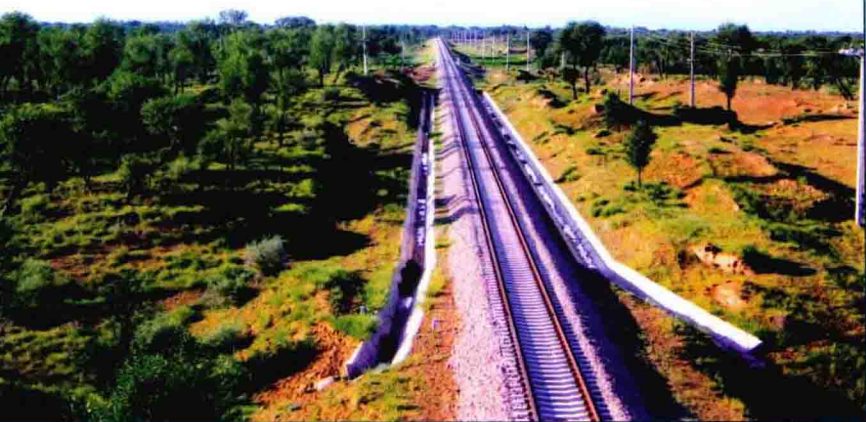
贯穿托克托县境南北的呼准铁路。
