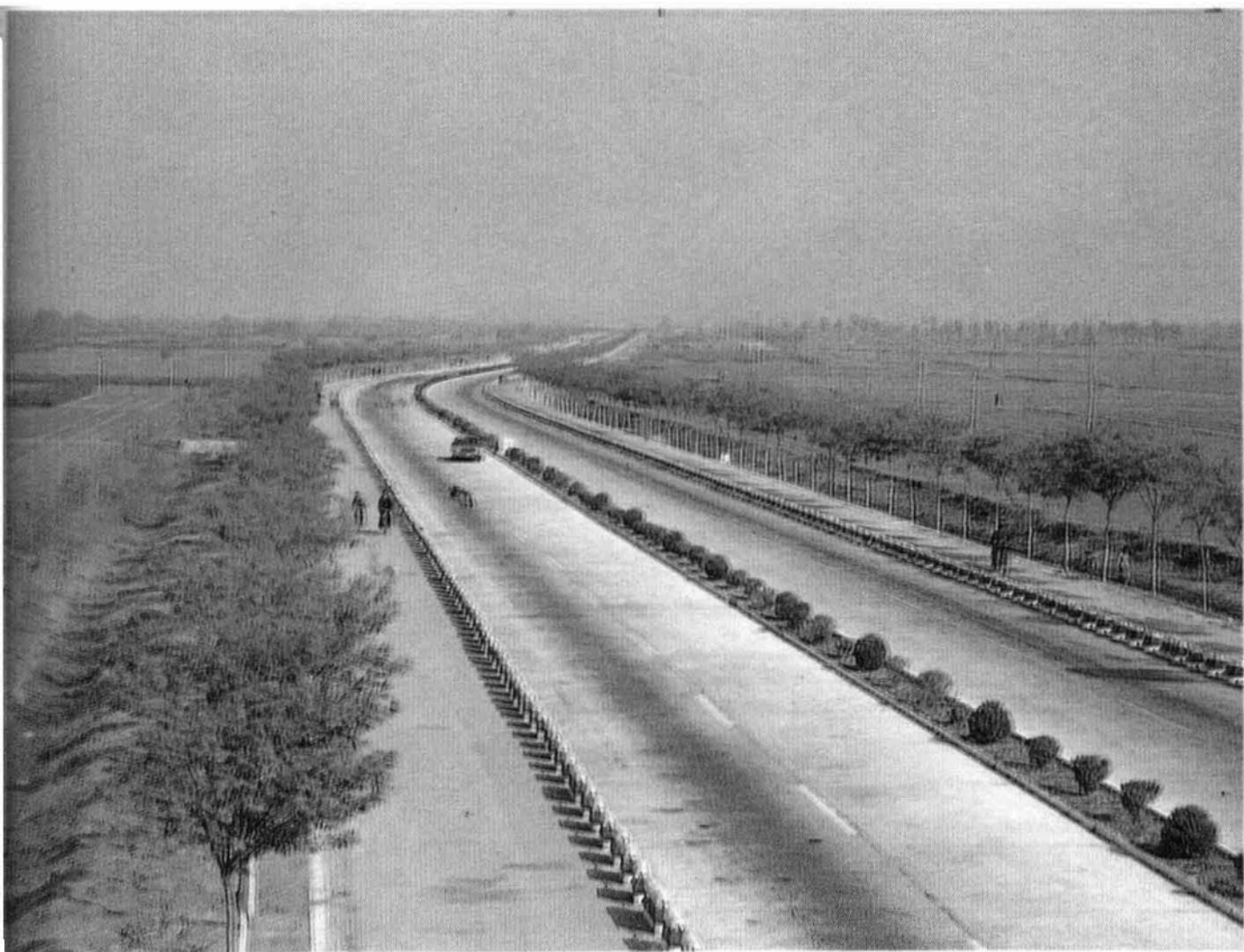
山东省泰安至曲阜汽车专用一级公路
