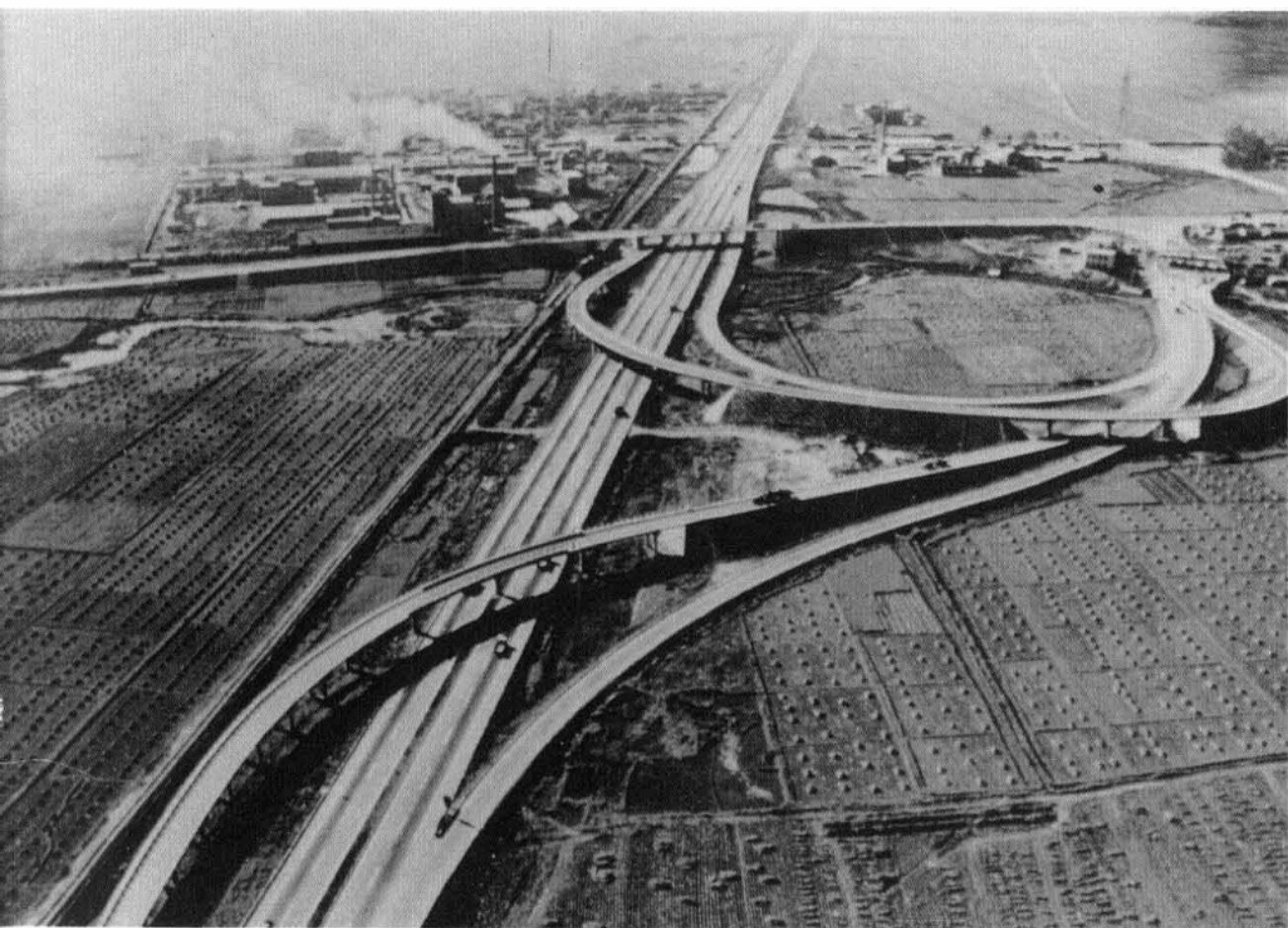
辽宁省沈阳至大连高速公路灯塔立交工程
