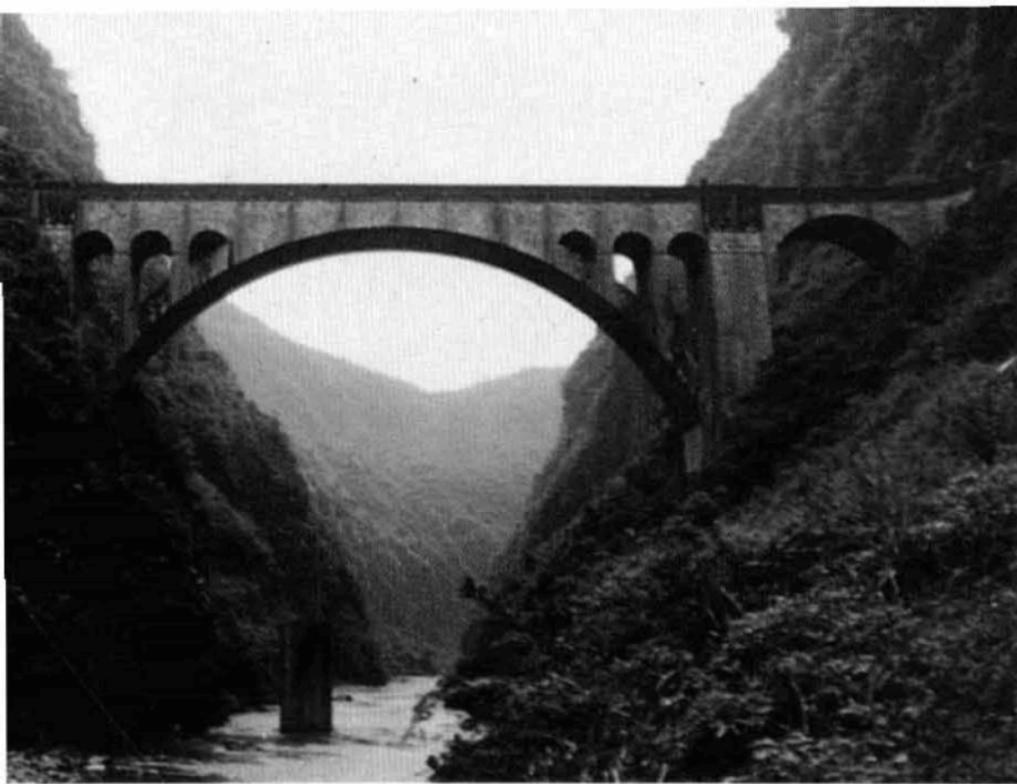
湖南省黄虎港石拱桥
