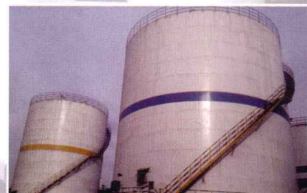
■ 2000m 3 大型平底贮槽
