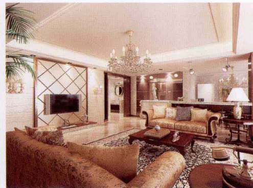
电视墙 [ 米黄大理石斜铺 + 木线条收口 ]
