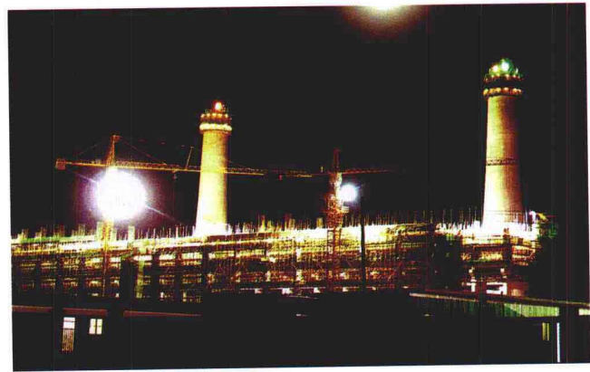
内蒙达拉特旗伊利电厂夜间施工现场
