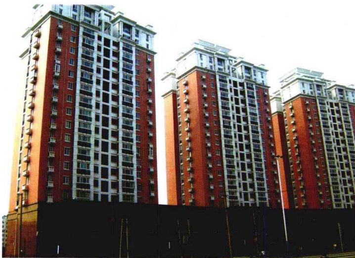
天津市金冠里高层住宅楼
