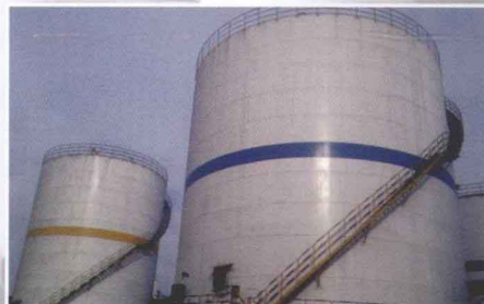
■ 2000m 3 大型平底贮槽
