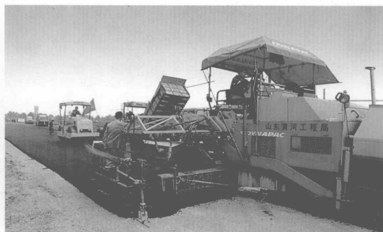
山东黄河工程局引进的德国产沥青摊铺机
