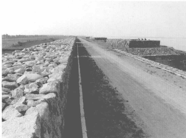
大荔雨林控导工程
