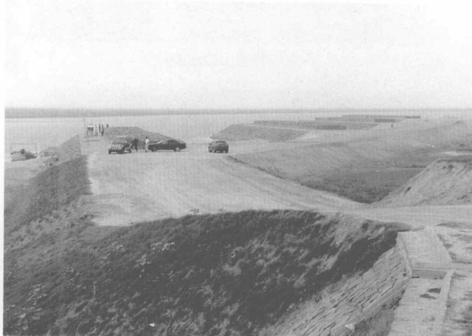
新建开封黑岗口控导工程
