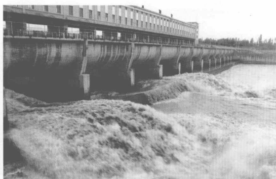
黑河第一次调水草滩庄枢纽开闸放水
