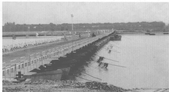
济南市河务局黄河浮桥
