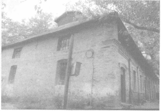
石佛寺沪商晒茧大楼 (东华摄)
