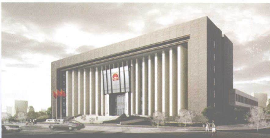
▲广州市萝岗区检察院业务用房。
