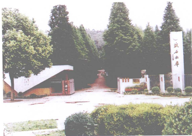
赋石水库大门全景
