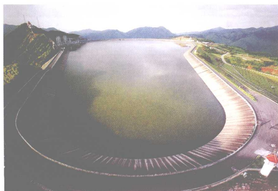
天荒坪抽水蓄能电站上水库全景
