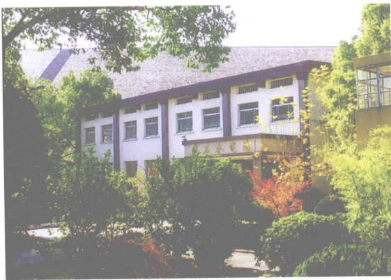
赋石水库电站厂房外景
