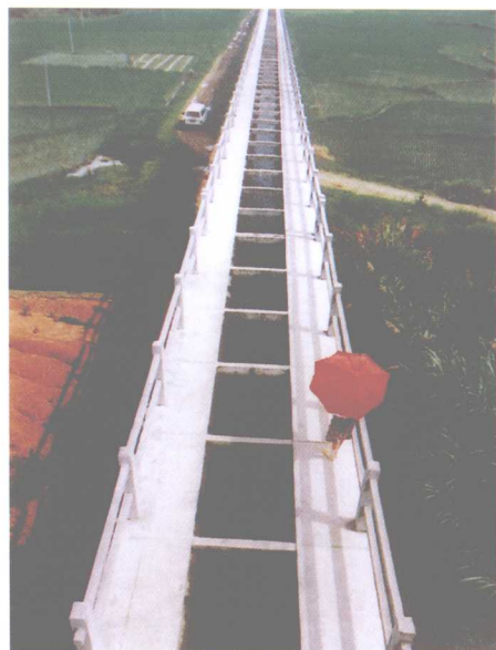
赋石渠道北山寺渡槽
