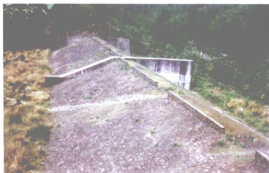
赋石水库非常溢洪道（自溃坝）
