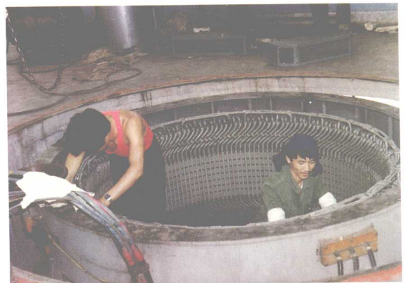
赋石电站机组大修
