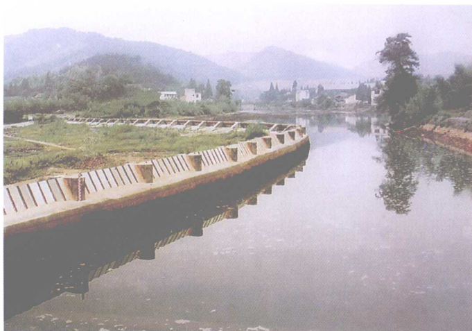
牛王坝（赋石渠道进水口）
