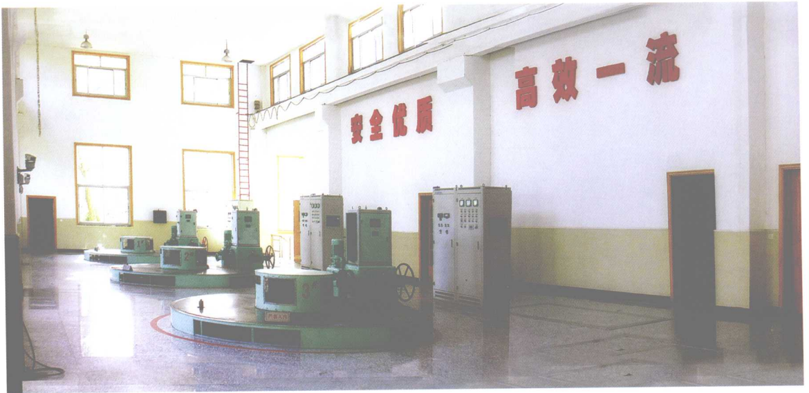
赋石水库电站厂房内景
