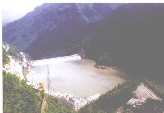
天荒坪抽水蓄能电站下水库全景
