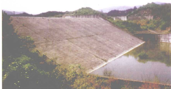
赋石水库溢洪道
