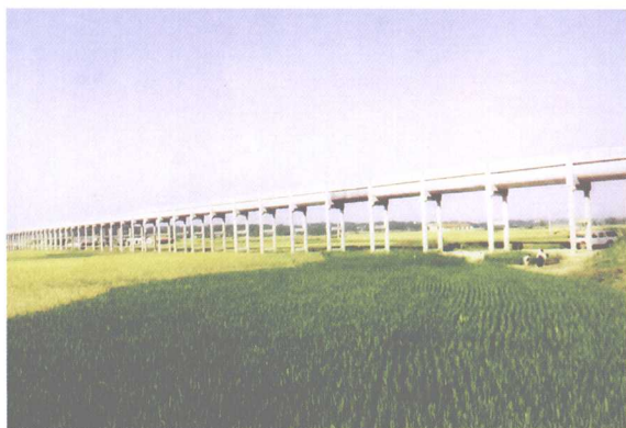
赋石渠道下北寺渡槽
