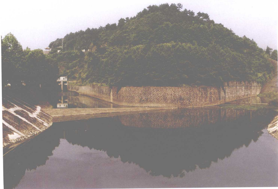
赋石水库泄洪洞、泄洪渠
