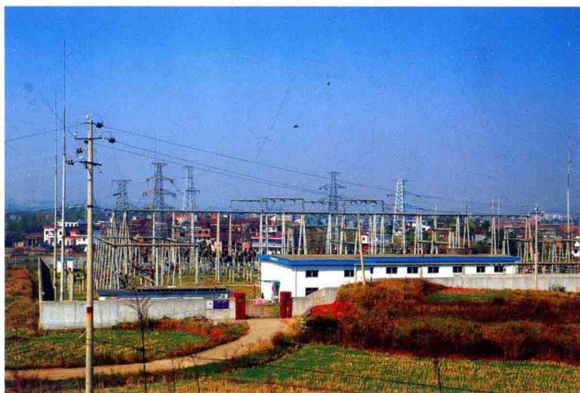
1998年起，全县实施农村电网改造工程。图为高亭变电站
