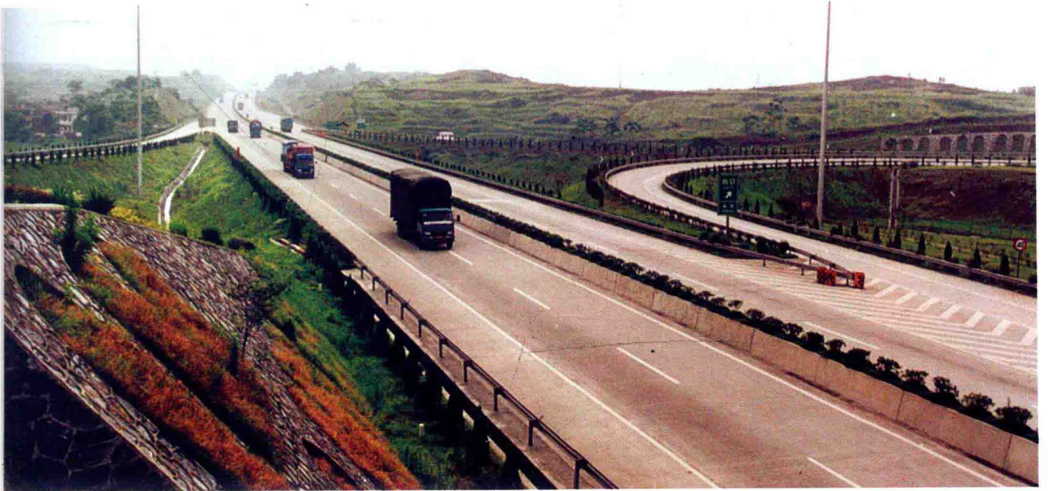
永兴县位于湘东南，京广铁路、107国道、京珠高速公路纵穿南北，省道212、213横贯东西。图为2001年竣工的京珠高速公路永兴出口处
