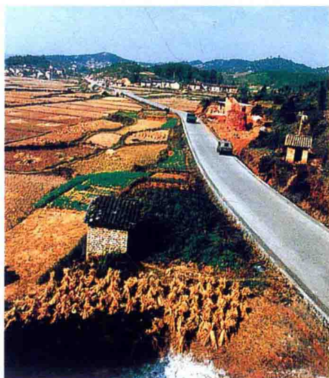
1989年~2002年，全县自然村村通公路率由2%增至85.3%，油市镇率先实现村村通水泥路。图为郴州市第一条乡村水泥路——雷复公路。
