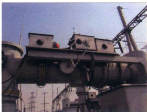
图 1-6 44101-3 隔离开关气室及机构照片
