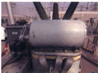
图 1-7 44101-3 隔离开关机构
