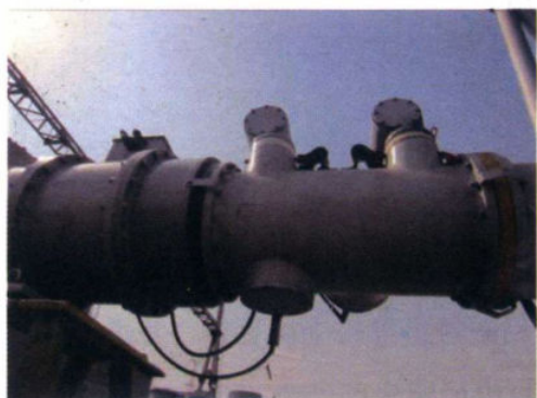
图 1-6 44101-3 隔离开关气室及机构照片
