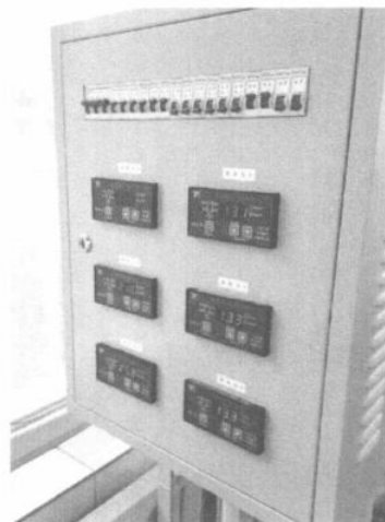
图1-13 水族箱循环设施智能控制系统（大连海洋大学所属实验室中的循环水养殖设施）
