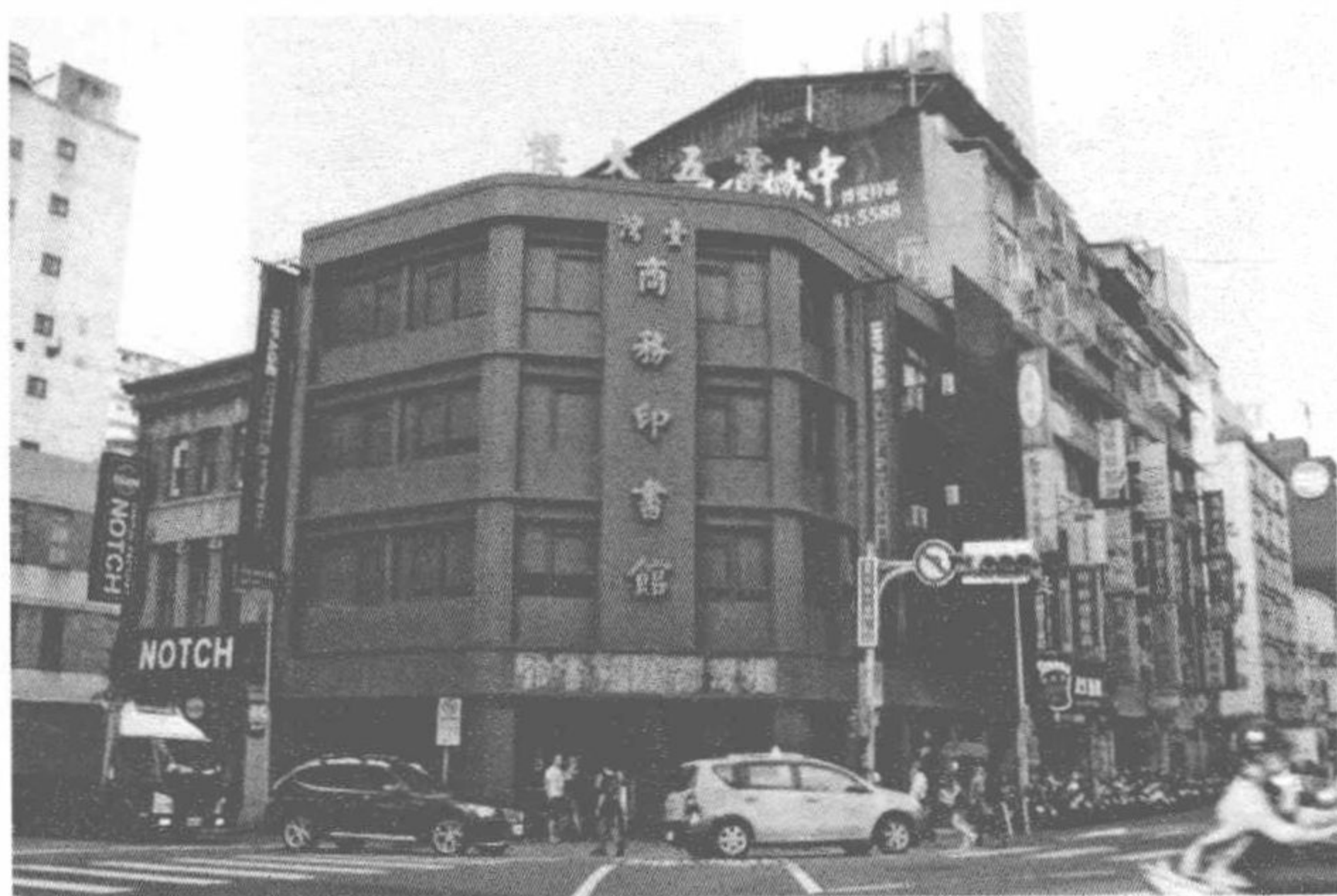
图6 台湾商务印书馆的云五大楼(台湾台北)
